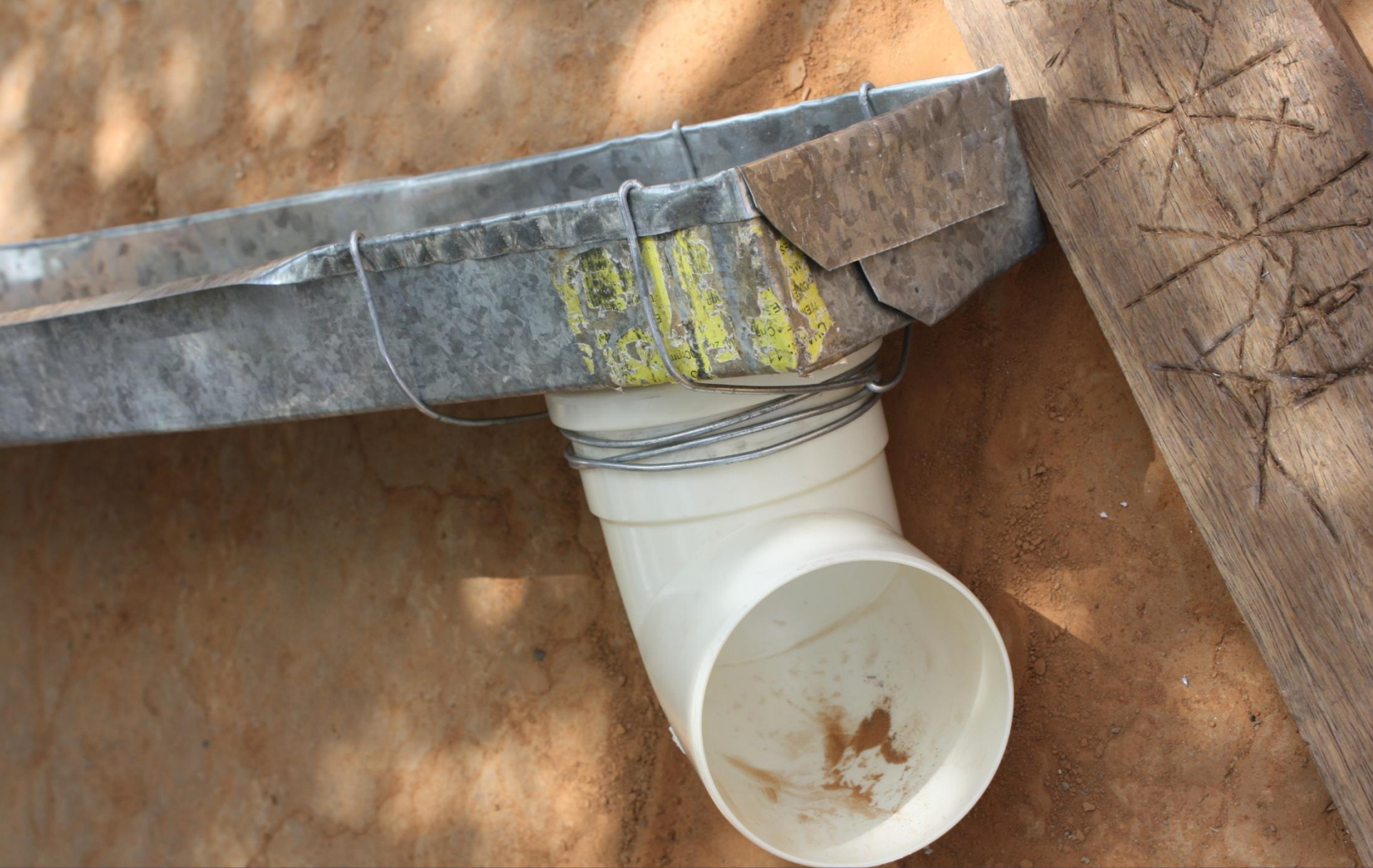
Joelho Instalado na Calha
