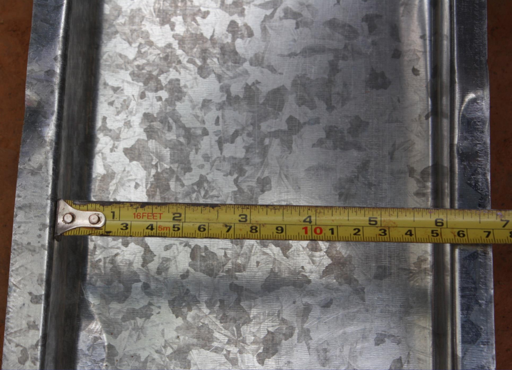
Medida da Parte Interior da Calha (06 cm)
