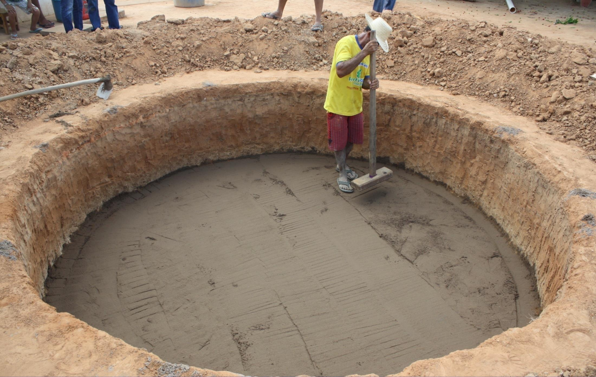
Nivelamento da Massa no Fundo do Buraco
