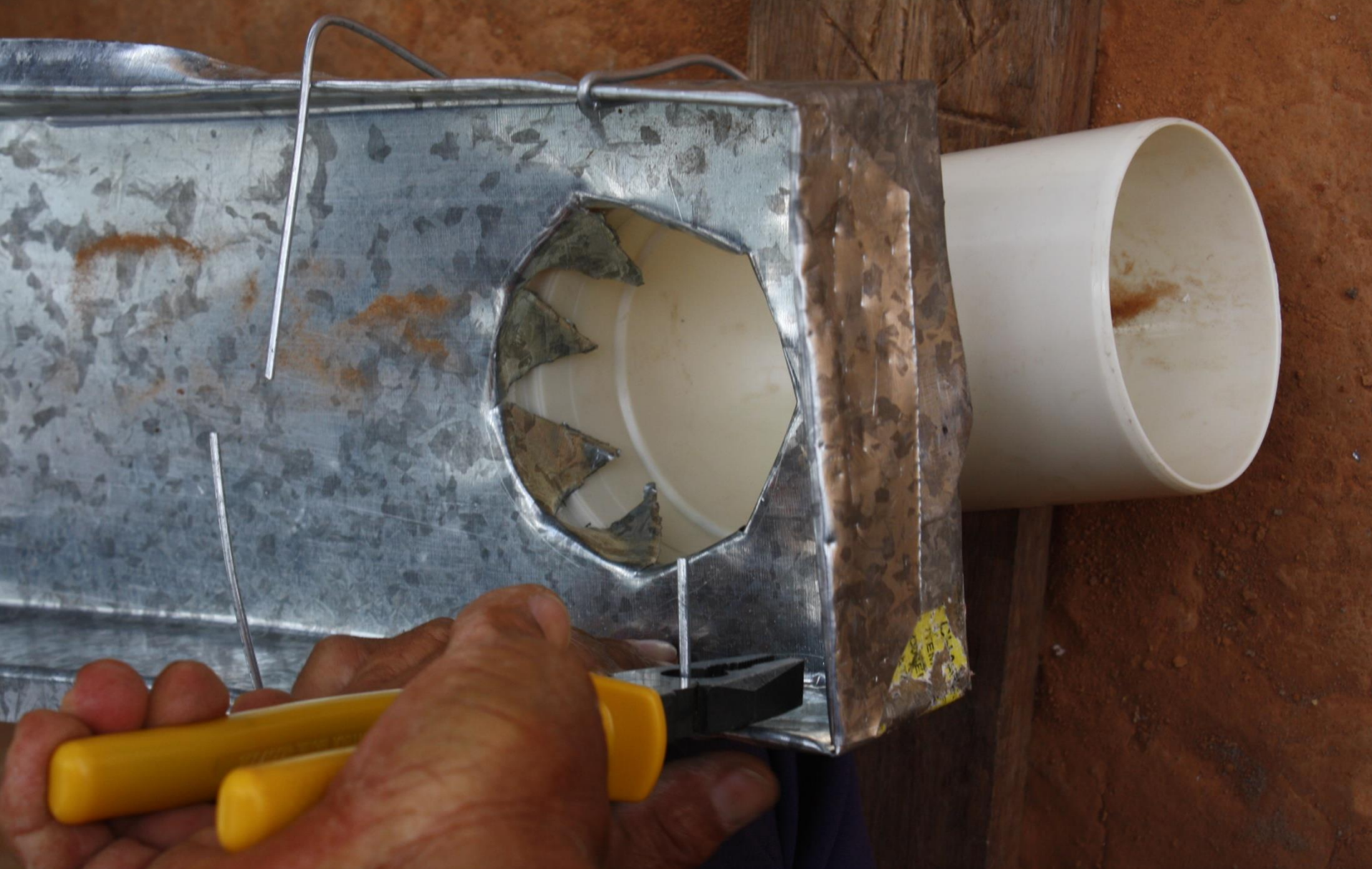
Amarração da Calha no Joelho do Cano
