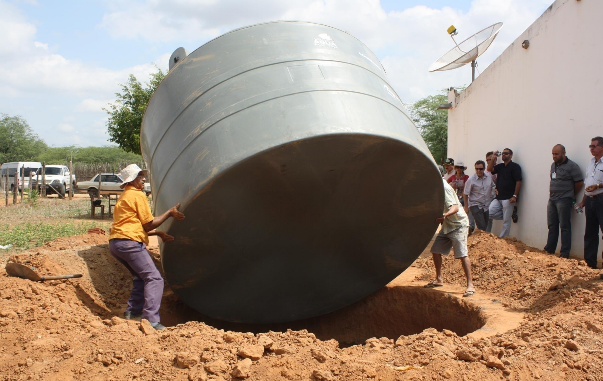
Colocação da Cisterna no Buraco
