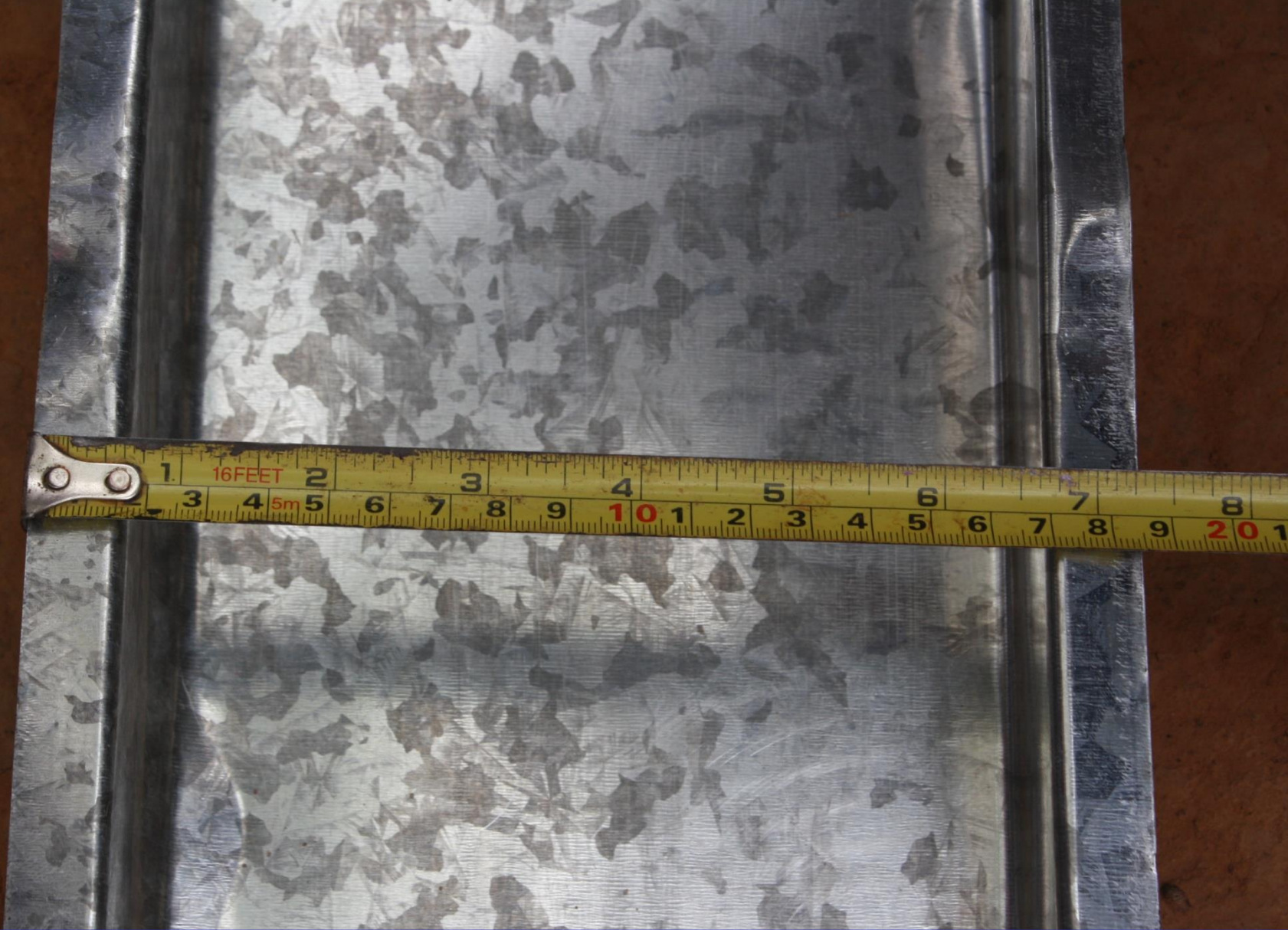
Medida da Calha na sua Parte Externa (09 cm)
